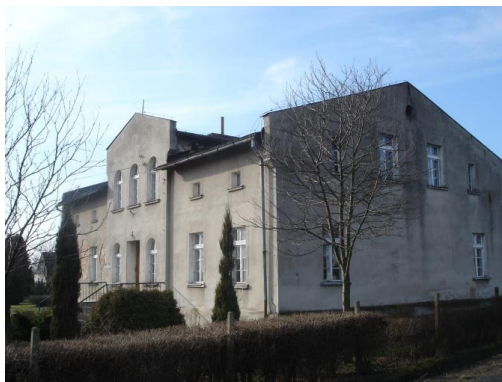
Zdjęcie 7. Budynek dawnej szkoły podstawowej
