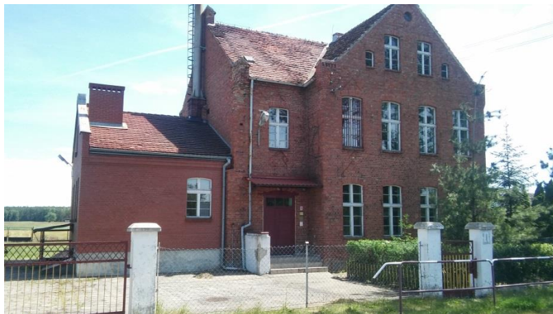
Zdjęcie 3. Budynek świetlicy w Wielkim Welczu
