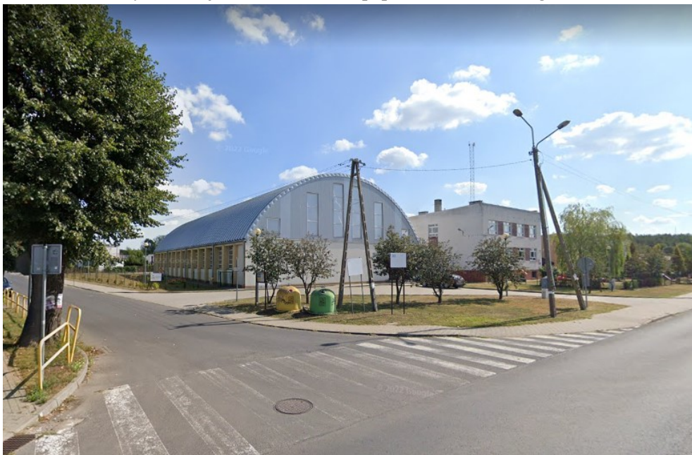
Fot. nr 2. Widok na tereny sąsiadujące z obszarem mpzp – zabudowa usługowa.
