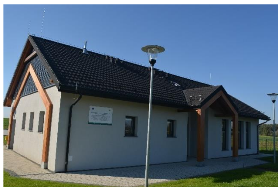
Świetlica wiejska w miejscowości Wielkie Lniska
