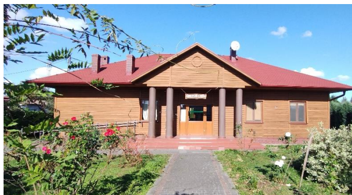
Świetlica wiejska w miejscowości Świerkocin
