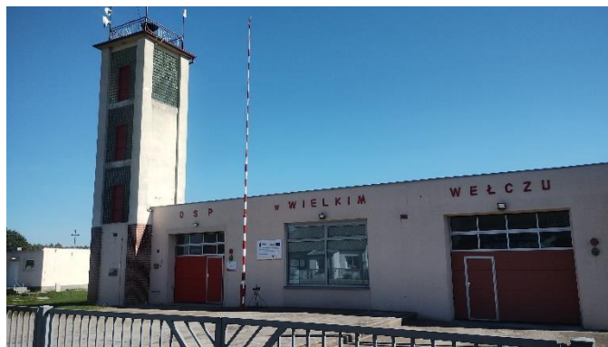
Remizo – świetlica w miejscowości Wielki Welcz Źródło: Urząd Gminy Grudziądz
