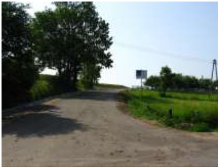
Zdjęcie. Droga gminna w miejscowości Gogolin
