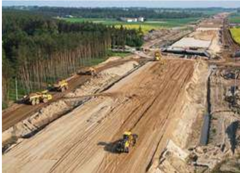
Fot. 1. Budowa autostrady A1
