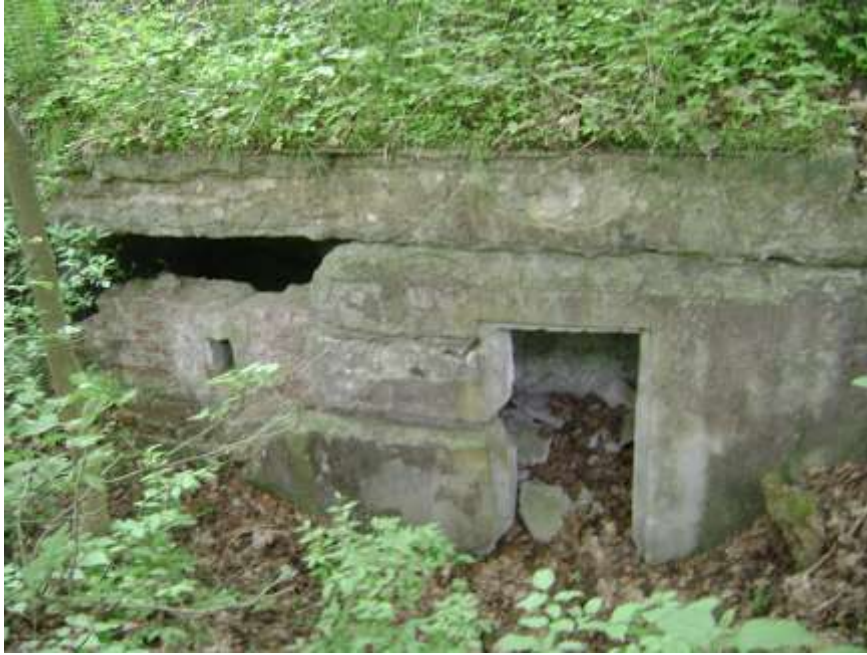
Fot. 2 Jedna z wartowni Fortu Parski.
