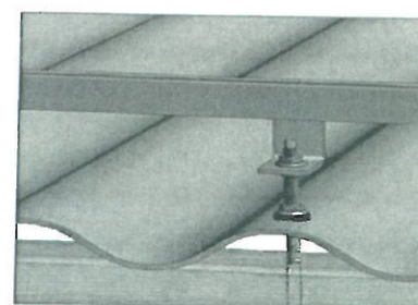
Stan po zamontowaniu
