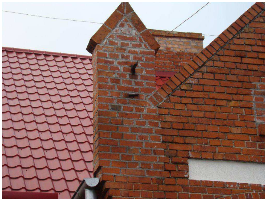
Fot.3. Widoczne miejsca wypełniania spoin zaprawą cementową.
