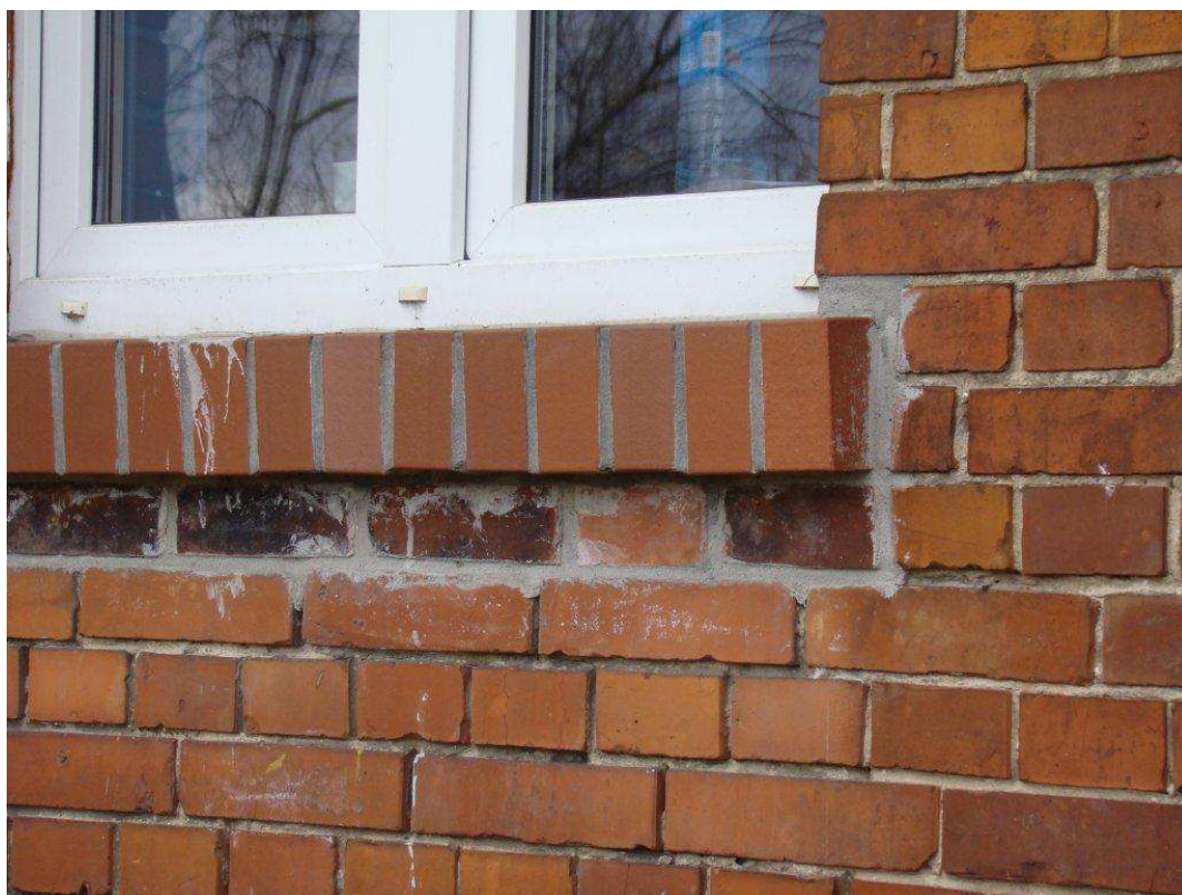
Fot.5. Parapet wykonany z źle dobranej cegły i zaprawy. Jeżeli proponowane wyżej zabiegi – wymiana zaprawy i korekta barwy cegieł laserunkiem nie dadzą zadowalającego rezultatu konieczna będzie wymiana cegieł parapetu.
