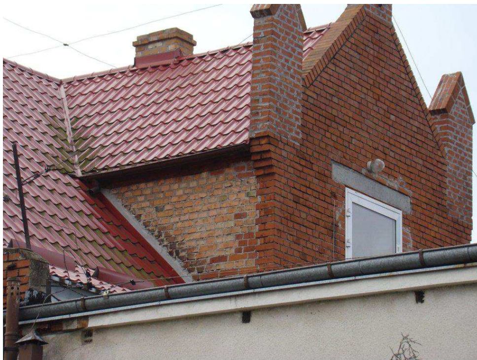
Fot.6. Widoczne pozostawione w stanie surowym fragmenty ścian i nadproże przy wyjściu ewakuacyjnym z I pietra.
