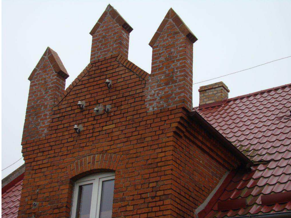
Fot.2. Widoczny fragment muru (sterczyny) przemurowany przy użyciu zaprawy na bazie cementu.
