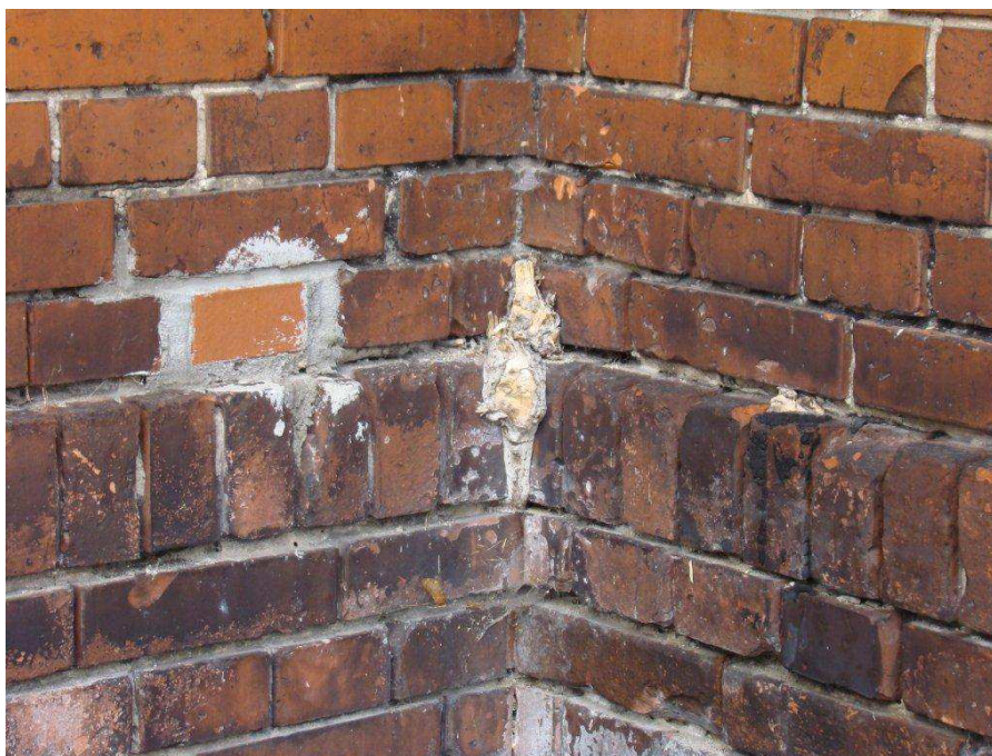
Fot.4.. Zabrudzenia ściany w rejonie wsypu węgla do kotłowni.
