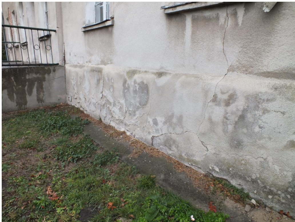
ul. Dusocin 9, elewacja frontowa, cokół, widoczne zawilgocenie i znaczne odspojenia tynku
