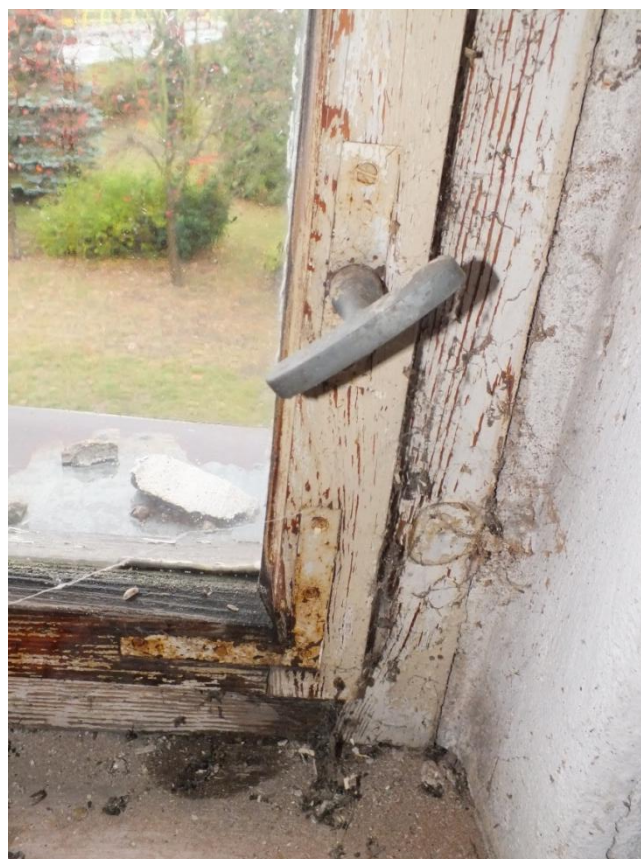
ul. Dusocin 9, stolarka okienna TYPU III, widoczne zawilgocenie ramiaka
