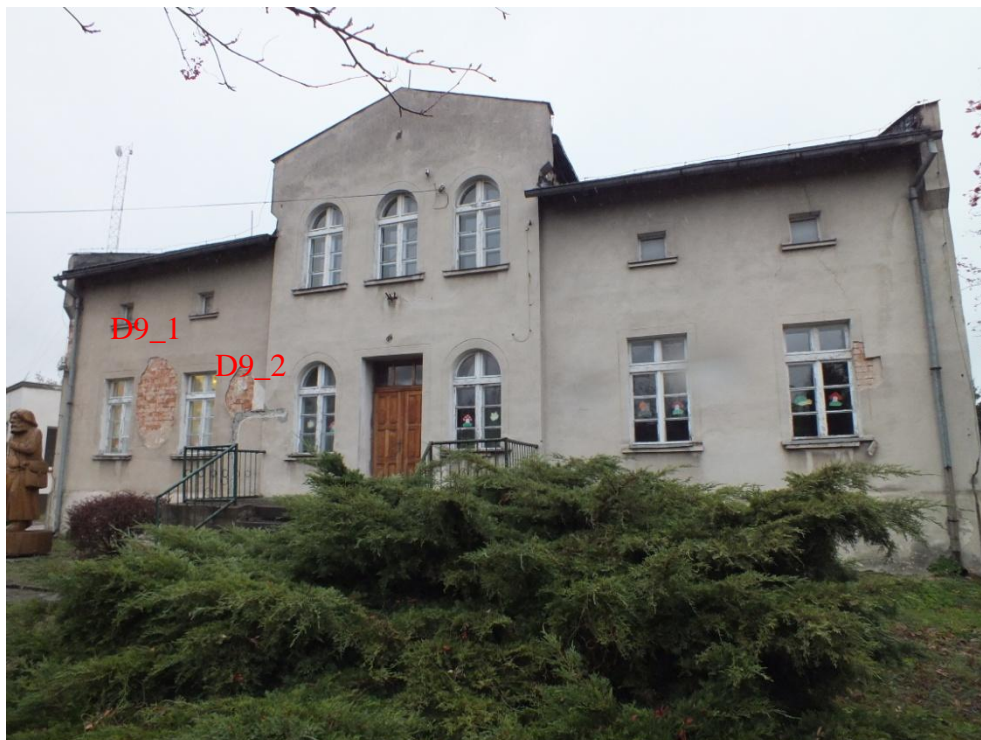
Budynek pod numerem 9 w Dusocinie, elewacja frontowa budynku z zaznaczeniem miejsca odspojen warstw.
