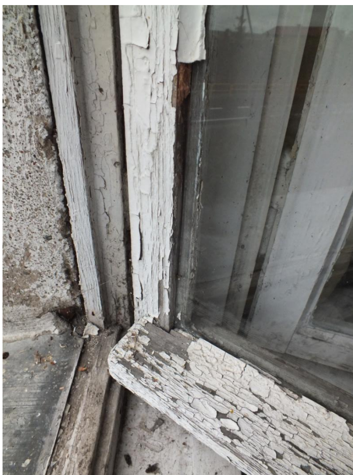
ul. Dusocin 9, stolarka okienna TYPU I, widoczne wysuszenie drewna i ubytki warstwy malarskiej
