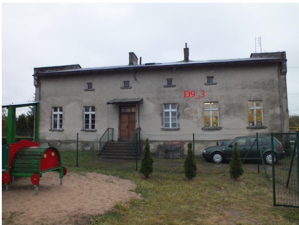
Budynek pod numerem 9 w Dusocinie, elewacja tylna budynku z zaznaczeniem miejsca odspojen warstw.
