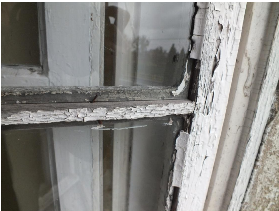
ul. Dusocin 9, stolarka okienna TYPU I, frontowe skrzydło, widoczny znaczny ubytek kitu szklarskiego
