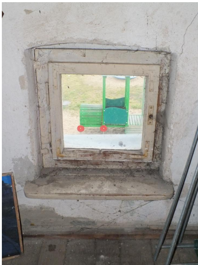
ul. Dusocin 9, stolarka okienna TYPU IV, widok od wnętrza, widoczne ubytki warstwy malarskiej i brak klamki
