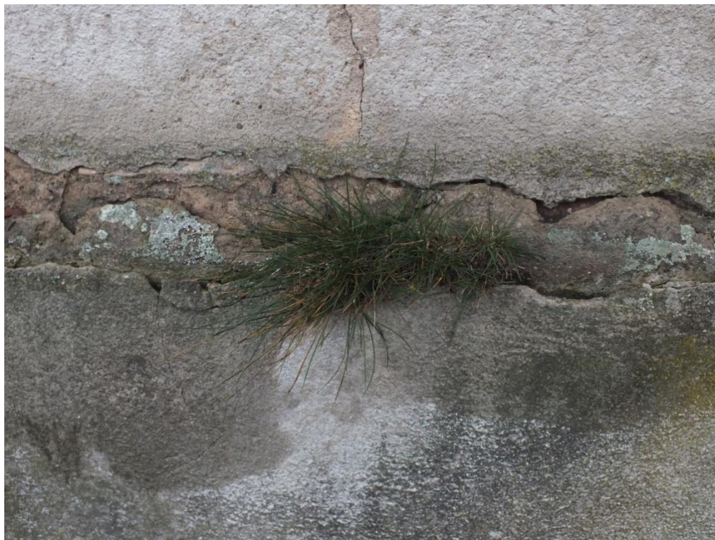
ul. Dusocin 9, elewacja tylna, cokół, widoczne zawilgocenie, odspojenia tynku
