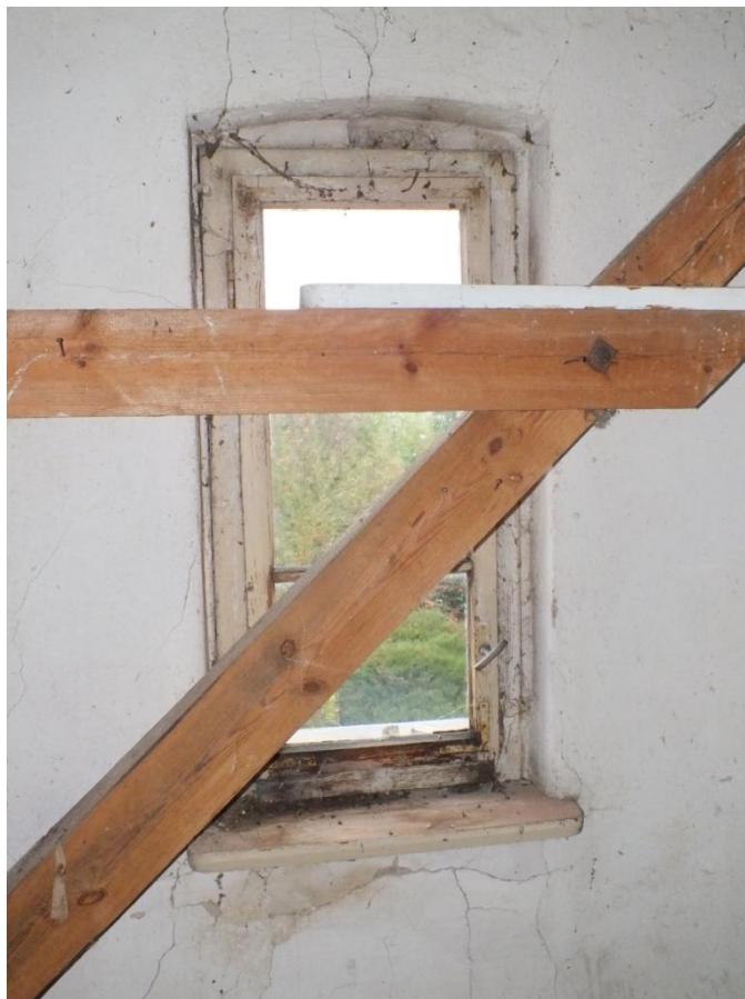
ul. Dusocin 9, stolarka okienna TYPU III, widok od wewnątrz, widoczne zacieki na dolnych partiach okna i ściany
