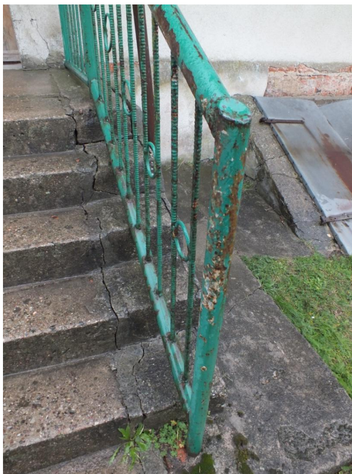
ul. Dusocin 9, elewacja tylna, schody zewnętrzne, widoczne znaczne spękania i korozja balustrady
