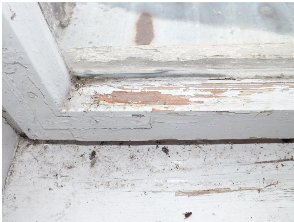
ul. Dusocin 9, stolarka okienna TYPU II, widoczne ubytki warstwy malarskiej
