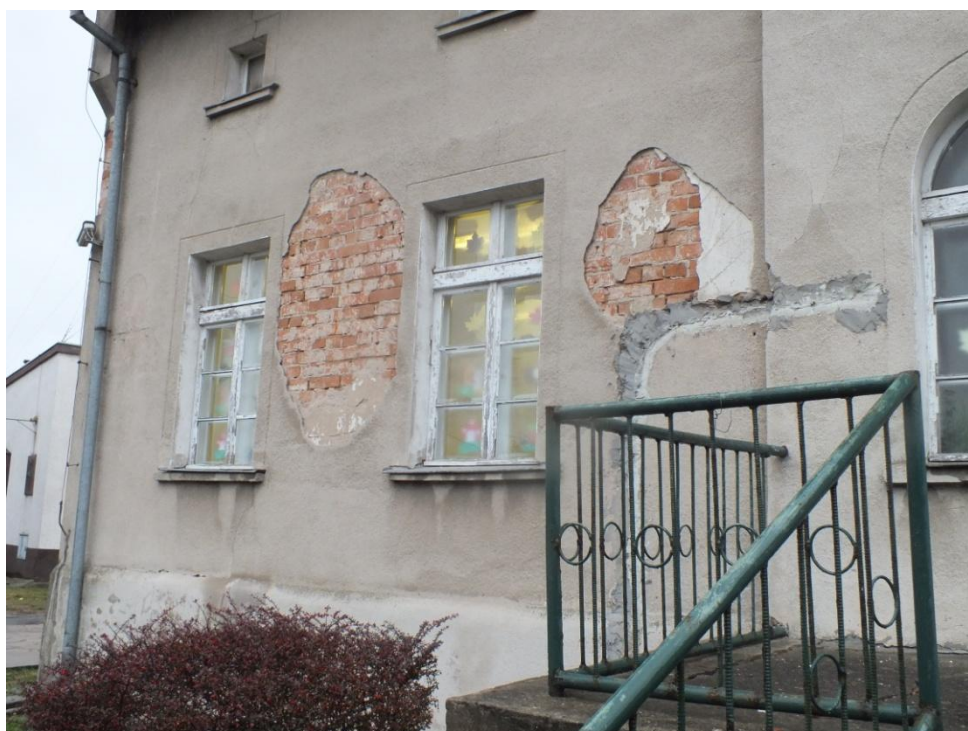
ul. Dusocin 9, elewacja frontowa, widoczne znaczne odspojenia tynku
