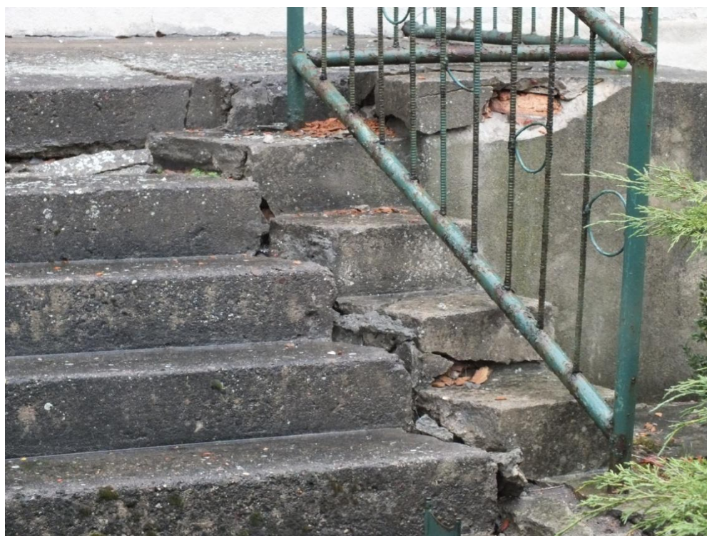
ul. Dusocin 9, zewnętrzne schody frontowe, widoczne silne spękania i osuwanie się konstrukcji
