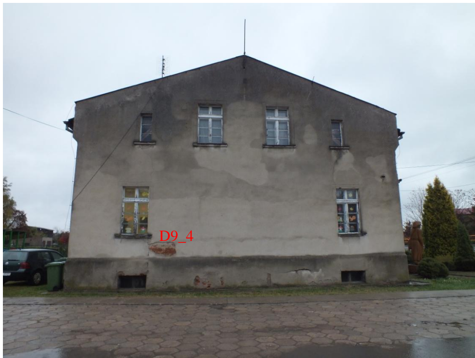
Budynek pod numerem 9 w Dusocinie, elewacja południowa budynku z zaznaczeniem miejsca odspojenia warstw.
