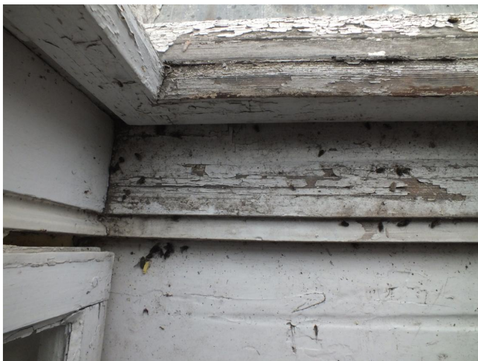
ul. Dusocin 9, stolarka okienna TYPU I, widoczne odspojenia warstwy malarskiej na dolnej partii ościeżnicy i ramiaka
