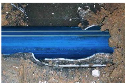
Rura ROBUST układana metodą burstingu
