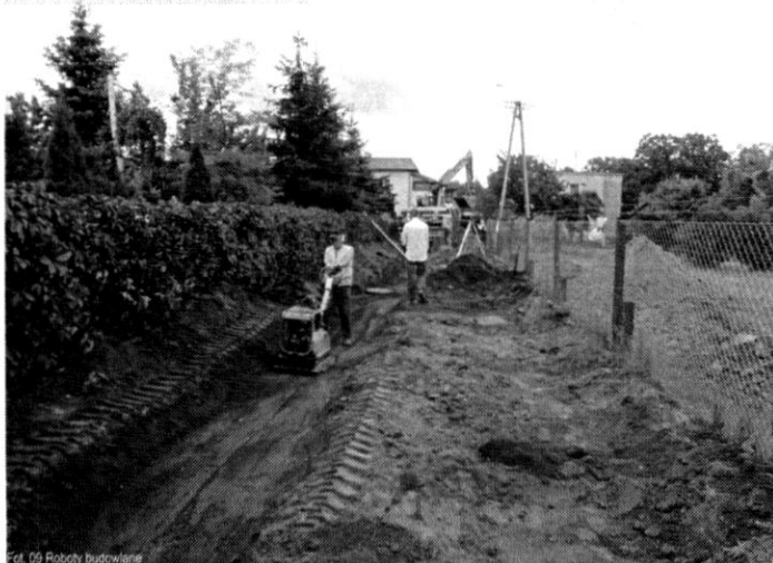
Fot. 09 Roboty budowlane
