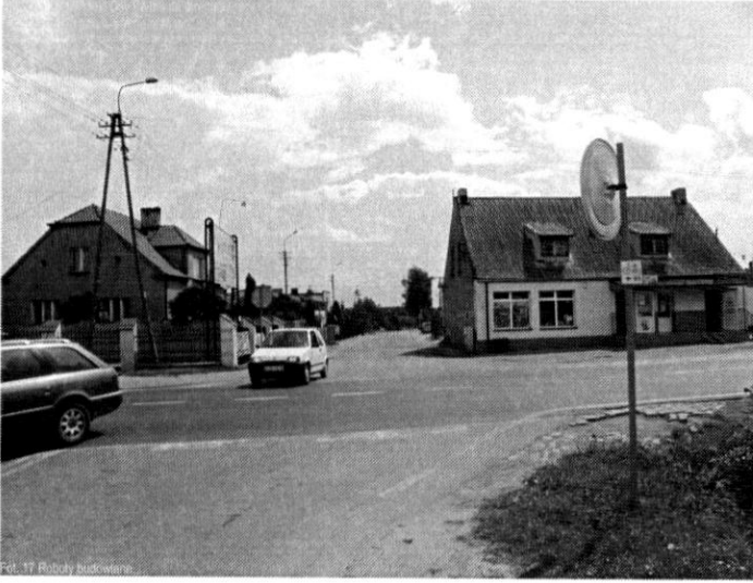
Fot. 17 Roboty budowlane
