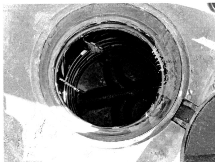
Fot. 12 Roboty budowlane
