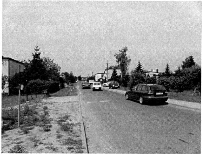
Fot. 18 Roboty budowlane
